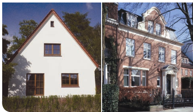
Bei Rotklinker- genauso sinnvoll wie bei Putzfassaden: Kerndämmung mit Knauf Insulation Supafil Cavity Wall.
