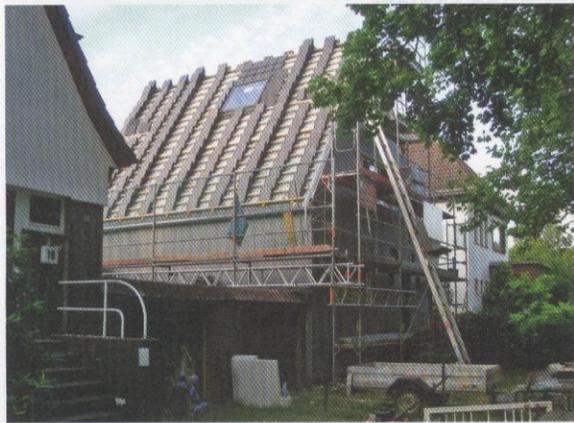
Oben: Die Aufsparrendämmung und Lattung ist bereits verlegt
